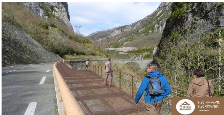
Le chemin se poursuivra bientôt par une passerelle en encorbellement
